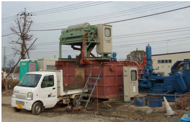
ボーリング現場 MW-4型
