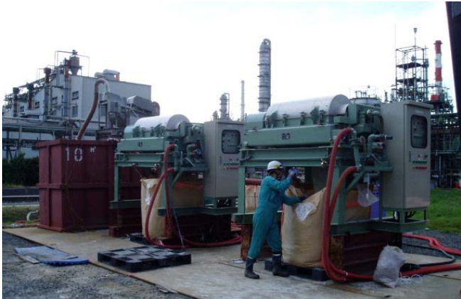
化学工場 MW-4型
