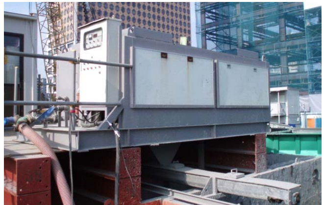
建設現場 HS-500MW型
